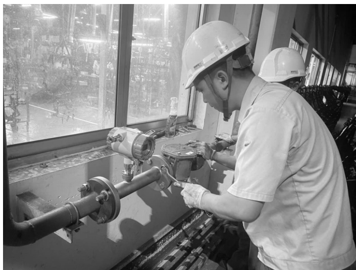
Hình 3. Triển khai số hóa hệ thống khí nén nhà máy linh kiện xe máy
