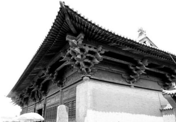
Hình 4: Dạng kết cấu gỗ đặc biệt có tác dụng hấp thụ năng lượng động đất (7)
