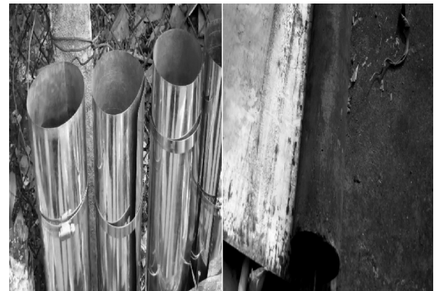
Hình 2: Khuôn và cọc nối thẳng đứng có lớp GEM
